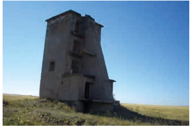
旧核実験場に残るモニタリング塔
